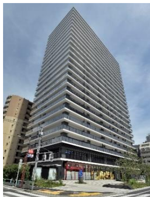
アルファグランデ千桜タワー 東京都千代田区 住宅・店舗・事務所・生活支援施設 2018年7月竣工
