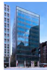
KDX新橋駅前ビル
