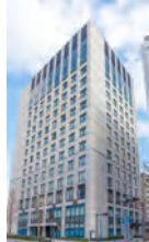
KDX横浜関内ビル
