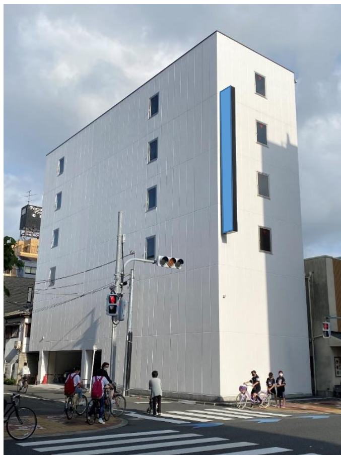
《（仮称）江戸川区松江 3 丁目新築工事 物件写真》
