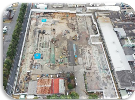
解体と土壤汚染対策を並行して施工した事例
