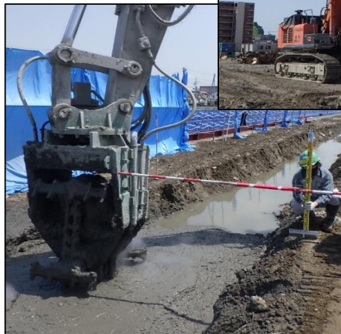
原位置封じ込め工法の作業状況 (地盤改良機による遮水壁の設置)
