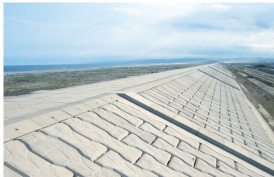
仙台湾南部海岸閉上北釜工区
