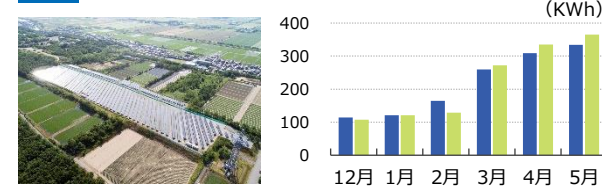
S-09 石川内灘太陽光発電所
