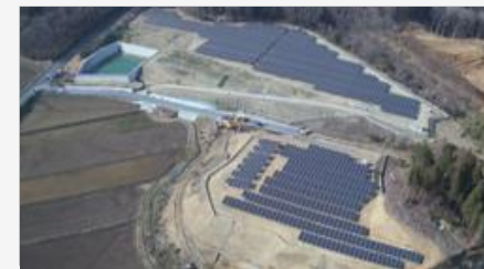
S-28 茨城常陸大宮太陽光発電所
