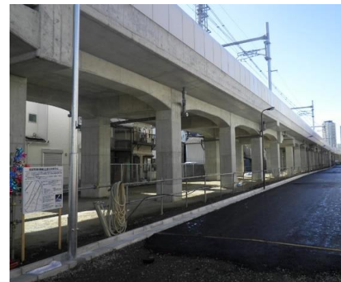
立体交差化を進める押上線 （写真は墨田区内）
