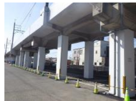
耐震補強後の高架橋柱
