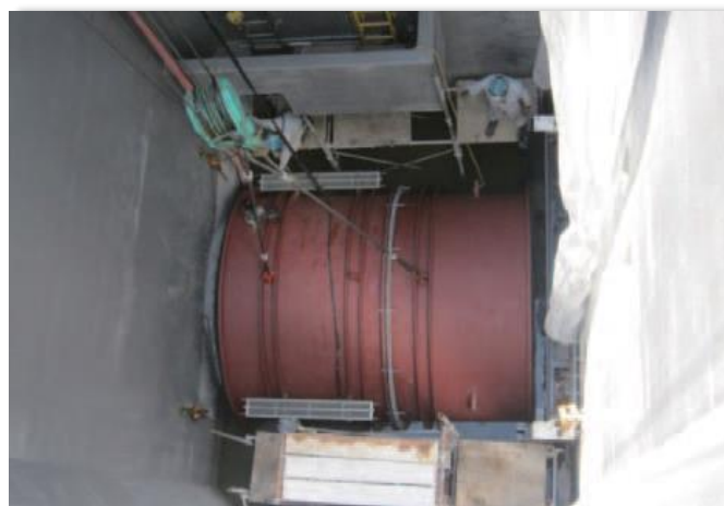
ゲート不断水工法
