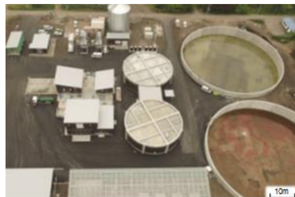
バイオガスプラント
