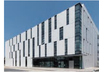
(南陽 新研究棟)
