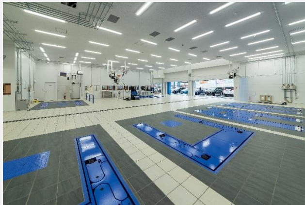
グッドスピードMEGA SUV 清水鳥坂店 (2021年9月 整備ピット新設)
