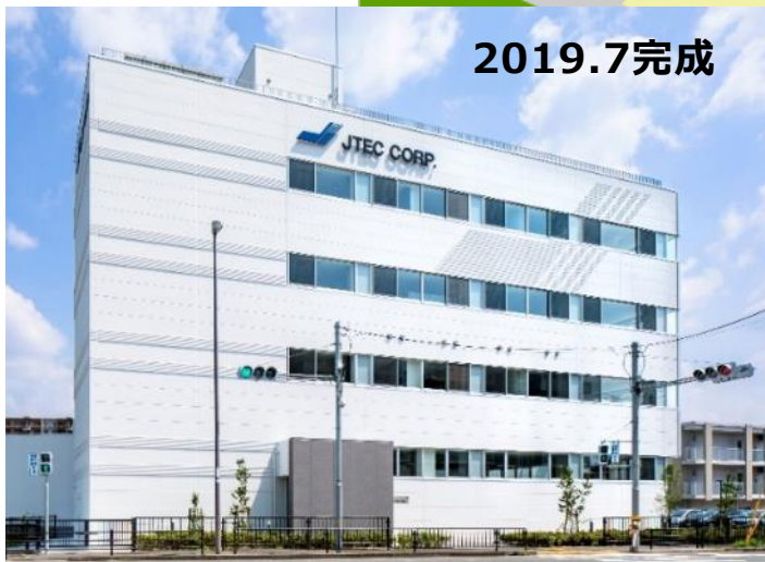
新本社・加工・計測棟：約5500m 2
