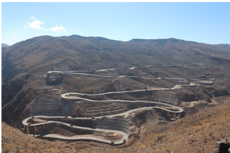
パキスタン国 東西道路改修事業（道路防災対策）
