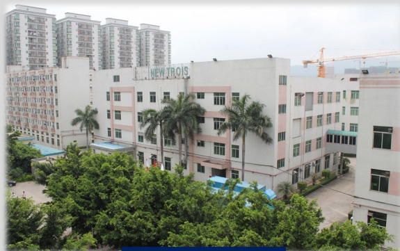
福永工場全景
