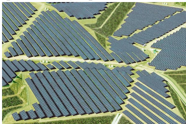
WWB(株)開発・施工 角田市太陽光発電所(宮城県角田市)
