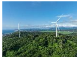
秋田県西目西ノ沢風力発電（2022年9月）
