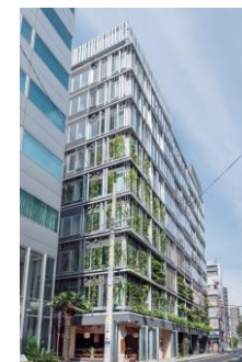
T-PLUS日本橋小伝馬町 (2022年4月竣工)
