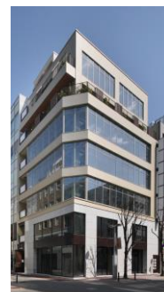
FUNDES天神西通り (2022年3月竣工)
