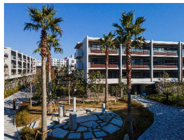
▲「ザ・パークハウス 新浦安マリンヴィラ」第1工区 外観
