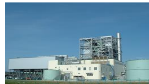
【 苫小牧発電所 】
