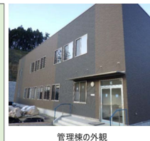
管理棟の外観
