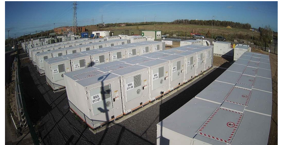
Ruien蓄電所建設現場
