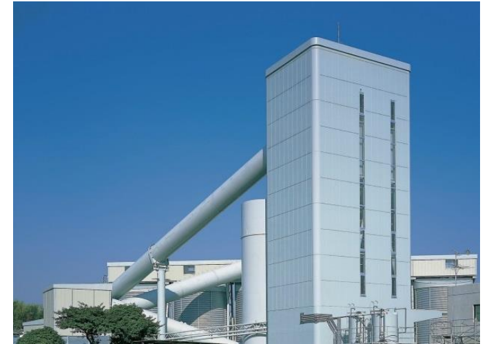
コンクリートプラント
