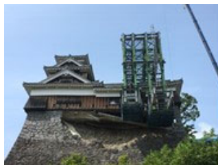
熊本城飯田丸倒壊防止設備
