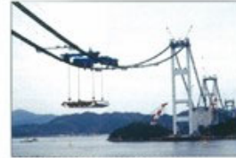
来島海峡大橋(本州四国連絡橋) 平成11年(1999年)愛媛県
