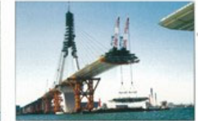
龍見つばさ橋(首都高速道路) 平成6年(1994年)徳島県
