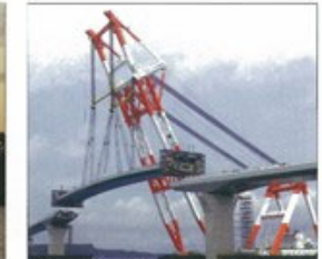
伊良部大橋(沖縄県)平成25年(2013年)沖縄県
