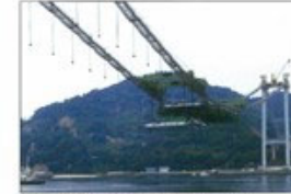
伯方・大島大橋(本州四国連絡橋) 昭和63年(1988年)愛媛県
