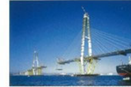
名港中央大橋(日本道路公社) 平成9年(1997年)愛知県
