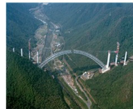
広島空港大橋架設風景
