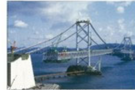
太陽門橋(本州四国連絡橋) 昭和60年(1985年)兵庫県～徳島県
