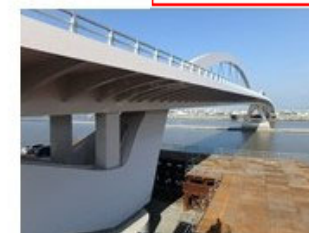
有明筑後川大橋
