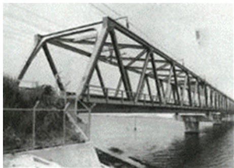
東海道新幹線江川橋梁
