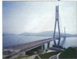
多々羅大橋(本州四国連絡橋) 平成11年(1999年)広島県～愛媛県
