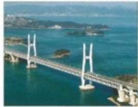
橋石島橋(本州四国連絡橋) 昭和63年(1988年)香川県
