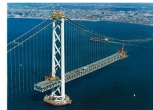
明石海峡大橋架設風景
