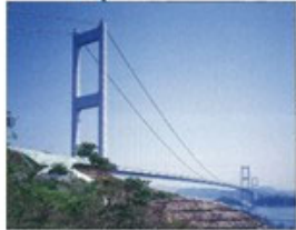
来島海峡大橋(本州四国連絡橋) 平成11年(1999年)愛媛県
