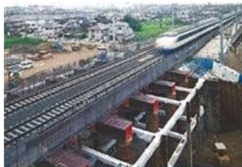
東海道新幹線箕輪架道橋
