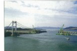
下津井瀬戸大橋(本州四国連絡橋) 昭和63年(1988年)岡山県～香川県
