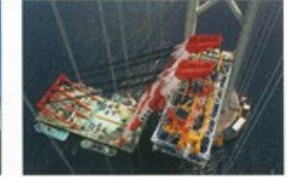
明石海峡大橋(本州四国連絡橋) 平成10年(1998年)兵庫県
