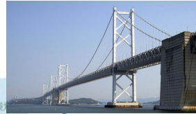
北備讃大橋・南備讃大橋(本州四国連絡橋) 昭和63年(1988年)香川県
