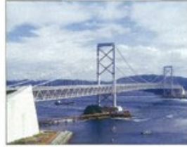
太陽門橋(本州四国連絡橋) 昭和60年(1985年)兵庫県～徳島県
