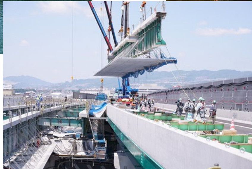
吹田JCT～中国池田IC間橋梁更新工事 西日本高速道路株式会社
