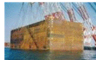
南本牧鋼製ケーソン
