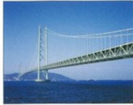
明石海峡大橋(本州四国連絡橋) 平成10年(1998年)兵庫県
