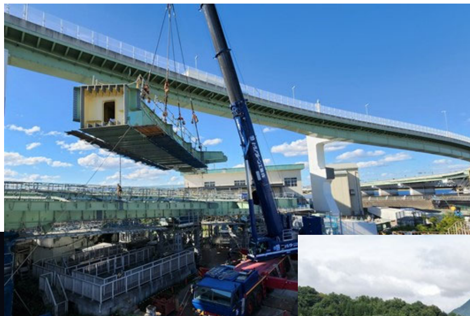
海老江工区鋼桁および鋼製橋脚工事 阪神高速道路株式会社
