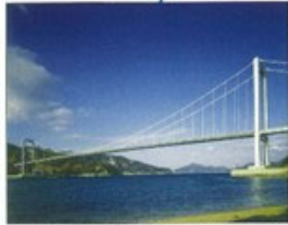
伯方・大島大橋(本州四国連絡橋) 昭和63年(1988年)愛媛県
