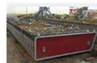
東京港海の森トンネル沈埋函
