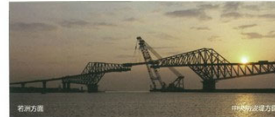
東京ゲートブリッジ(国土交通省関東地方整備局東京港湾事務所)平成22年(2010年)東京都
