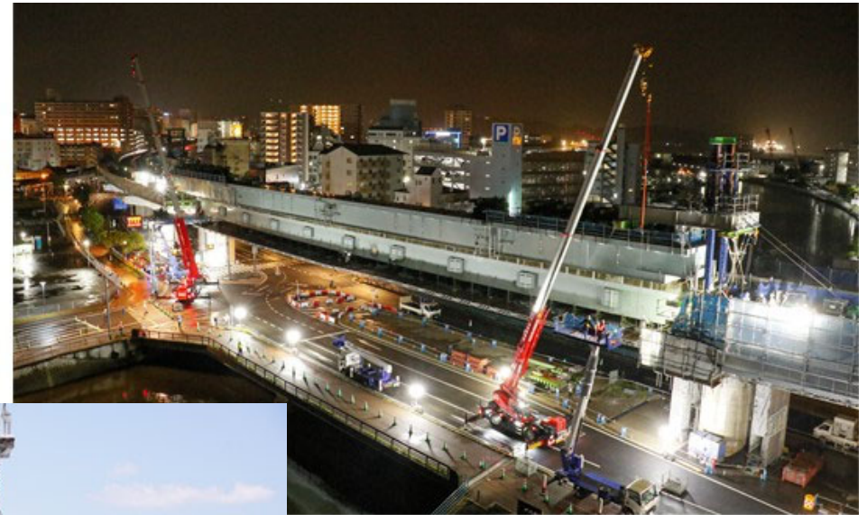
佐世保高架橋拡幅工事 西日本高速道路株式会社
