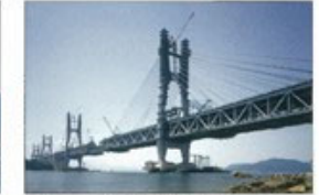
橋石島橋(本州四国連絡橋) 昭和63年(1988年)香川県
