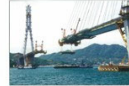
多々羅大橋(本州四国連絡橋) 平成11年(1999年)広島県～愛媛県
