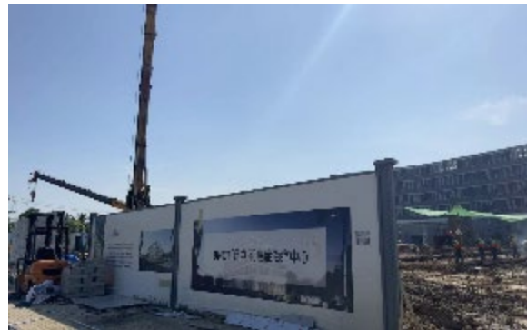
BNCTセンター建設現場
