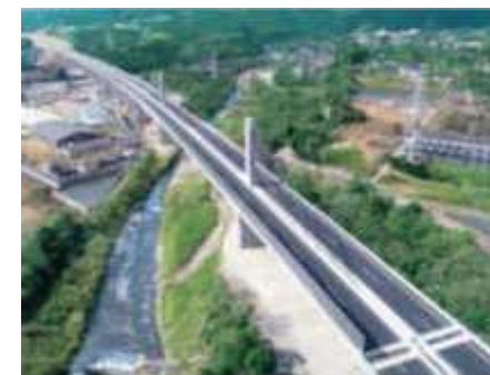
新名神高速道路菟野第二高架橋他3橋 (PC上部工) 工事
