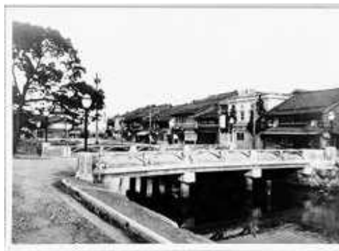
長生橋（石川県七尾市）
