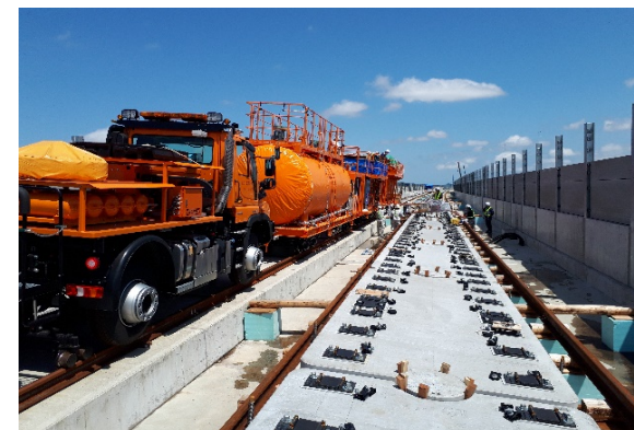
北陸新幹線 福井軌道敷設他工事
