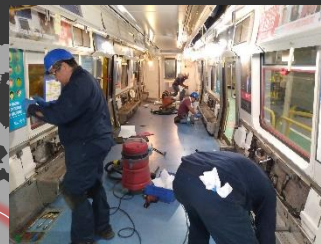
PA-5更新工事
