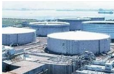
石油貯蔵タンク
