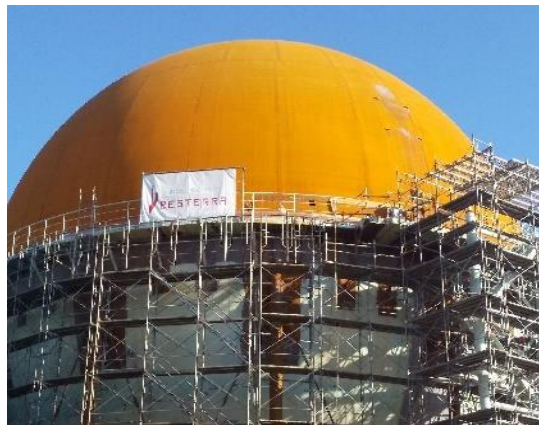
球形ガスホルダー（上半球ブラスト済み）
