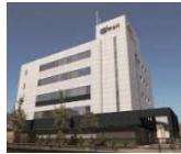
本社(大阪市西淀川区)
