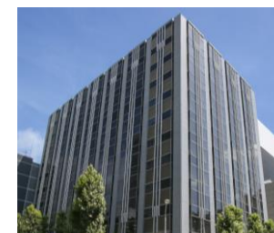
各保有物件設備の更新(共用部照明のLED化等) (MIテラス名古屋伏見)
