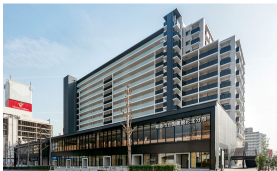
マンション工事
