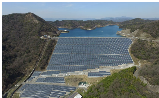
神谷ダム太陽光発電施設
