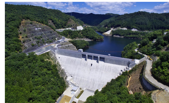
金出地ダム堤体
