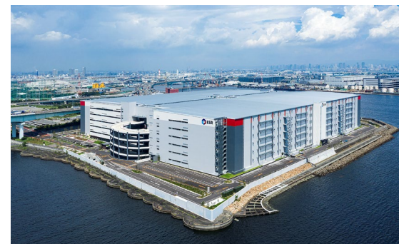
物流施設工事
