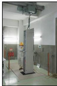
(保護リレー新設・改良（取替）・除却工事)
