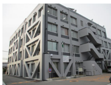
(一般建物の建築工事)
