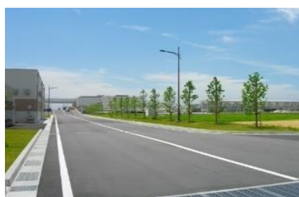
(緑地改修・新設工事)
