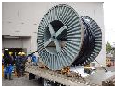
(地中送電線工事)
