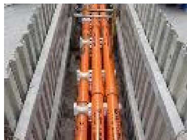
(地中送電管路工事)
