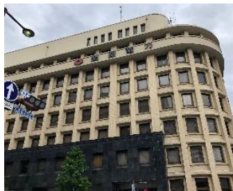
(社屋建物の保全工事)
