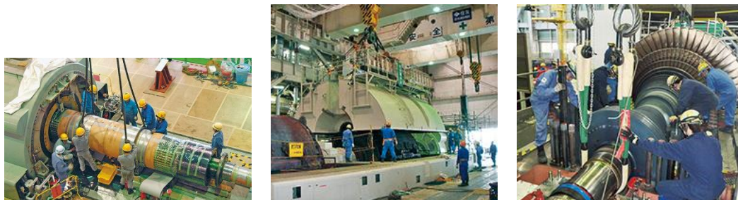
(火力発電所の定期点検工事、設備修繕工事)
