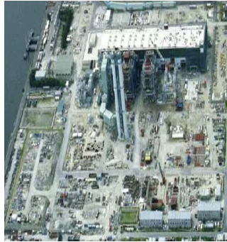
(火力発電所の建設工事、除却工事)
