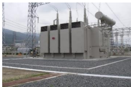
(機器基礎工事)
