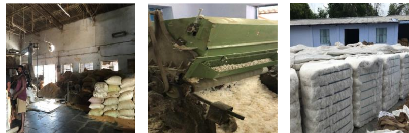
現地の廃校跡地を改修したジニング工場の立ち上げ
