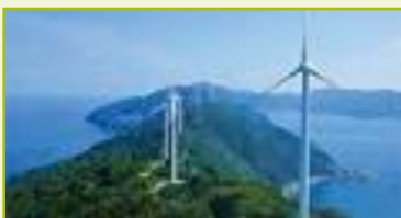
三崎ウインドパワー (20MW)
