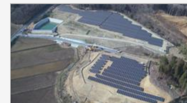
S-28 茨城常陸大宮太陽光発電所
