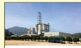
敦賀グリーンパワー (33MW)
