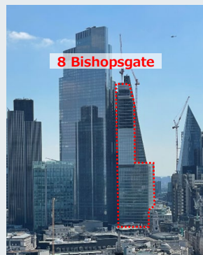
▲外観写真 (2022年7月)
