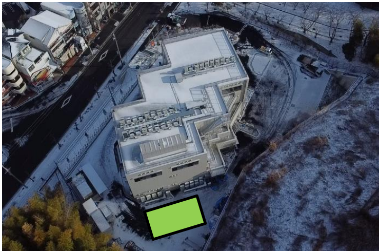
放射線治療棟建設予定地
