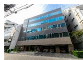
東京都中央区築地 一棟収益ビル
