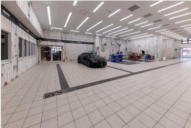
グッドスピード MEGA 輸入車 名古屋昭和橋店 (2022年8月 整備ピット新設)
