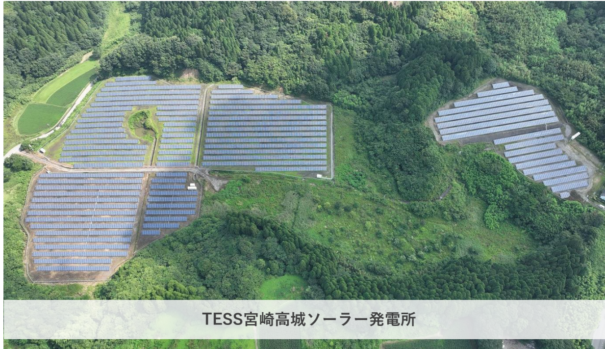
（左上より第一発電所、第二発電所、第四発電所。左下は第三発電所。）
