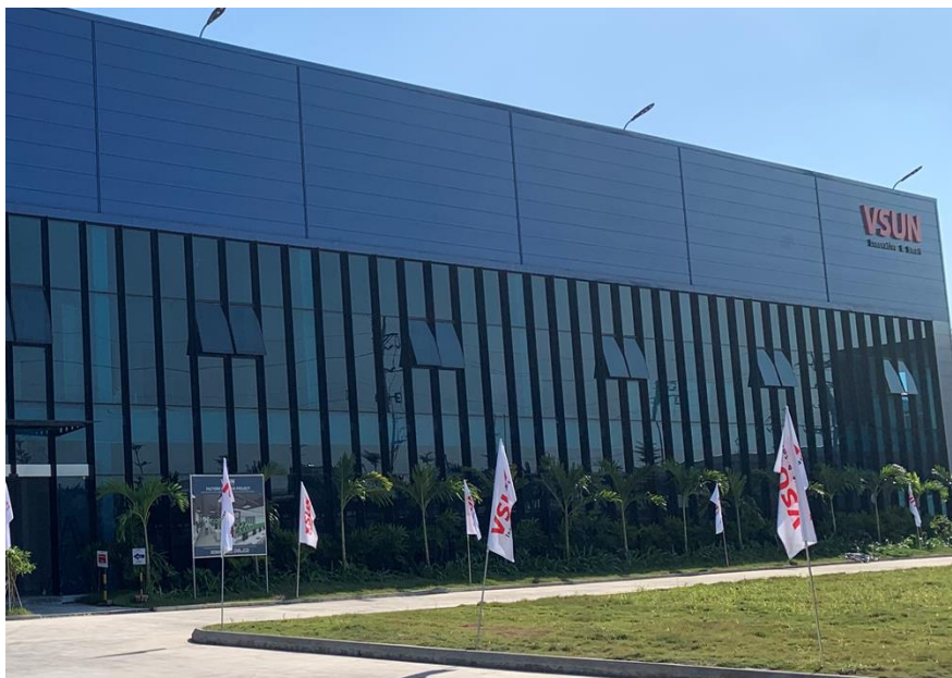
【第4工場 外観/ベトナム国】
