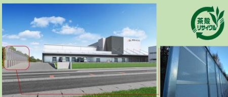
東洋メビウス熊谷物流センター 茶殻配合防音パネルを採用した防音壁
