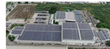
現地半導体メーカー工場への屋上設置
