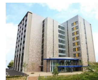
大阪大学テクノアライアンス棟 (再生誘導医学協働研究所6,7F)
