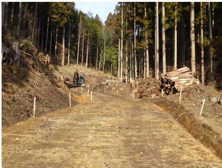
仮設道路工事
