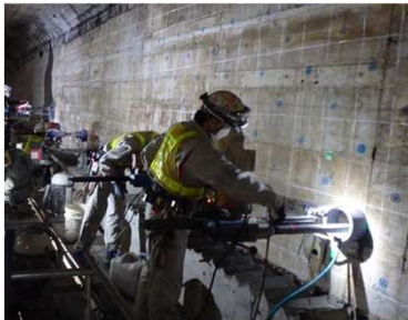
耐震補強工事（左：高架橋柱 右：トンネル区間）
