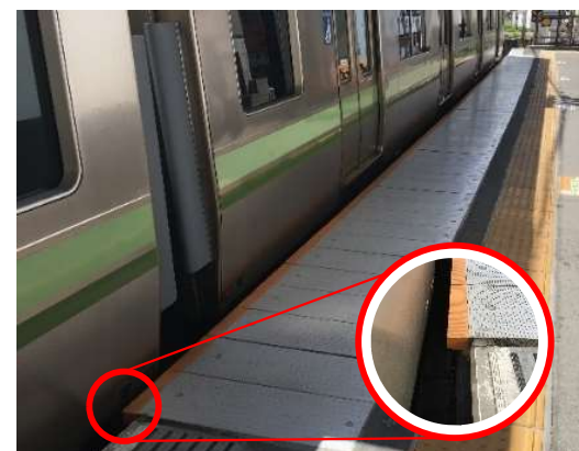
転落防止ゴムの設置 （隙間対策）
