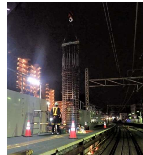
施工状況 芦花公園駅での基礎工事の様子
