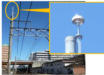
雷害対策（避雷針の設置）
