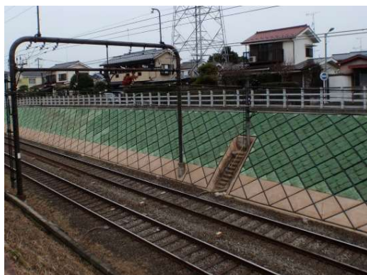
法面補強工事
