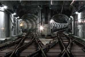
工事完了後の調布駅
