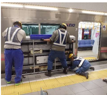
ホームドアの整備（左：施工中 右：施工後）
