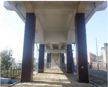
耐震補強工事（左：高架橋柱 右：トンネル区間）
