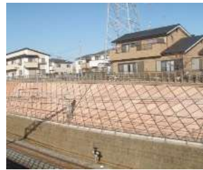
大雨対策 （法面補強工事）
