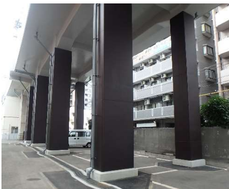
高架橋耐震補強
