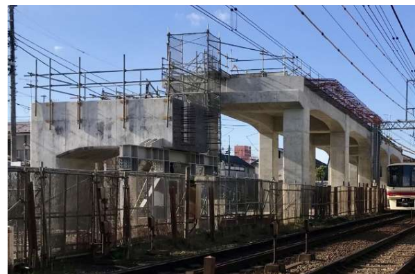
一部完成した高架橋躯体
