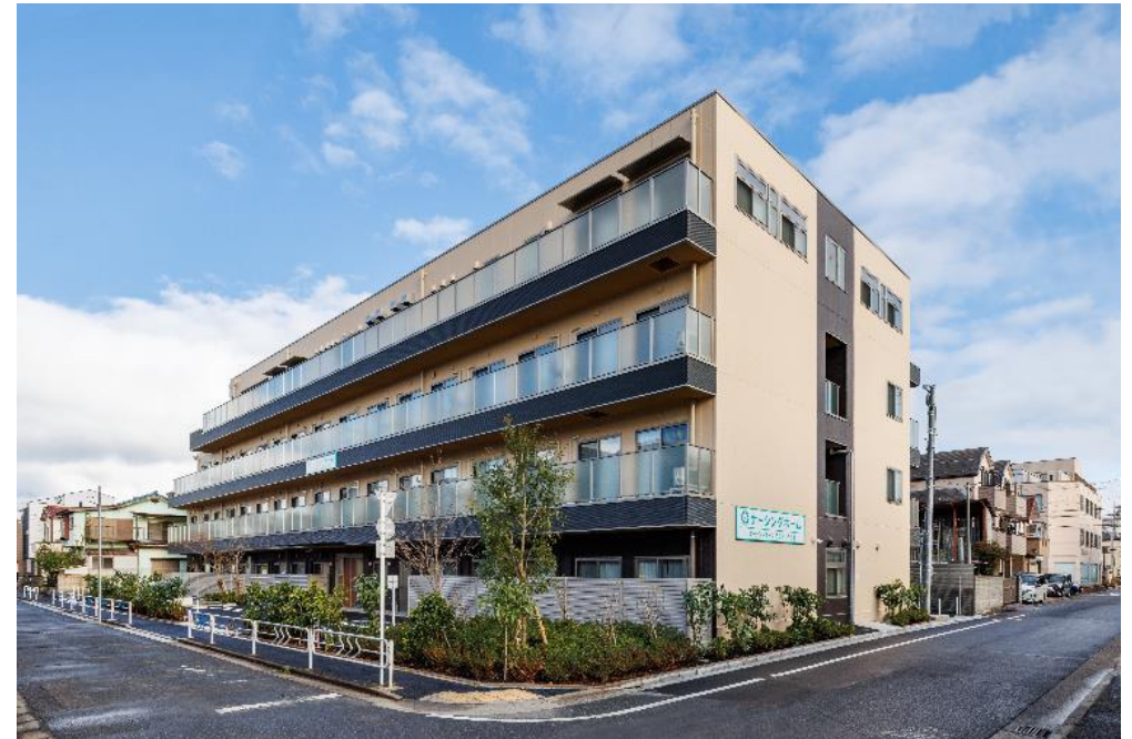
(仮)南篠崎ナーシングホーム
