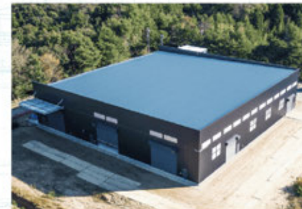
▲ 2022年12月現在 建屋完成
