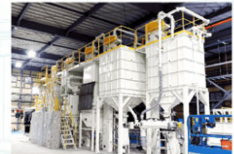
▲ 設備搬入状況の一例
