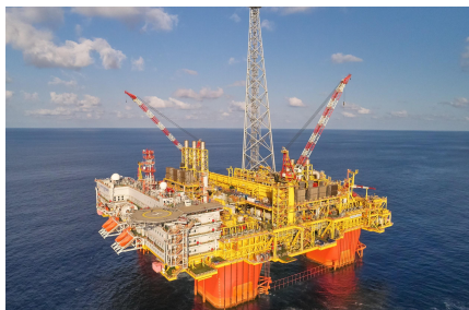
イクシス沖合生産・処理施設(CPF※) ※Central Processing Facility
