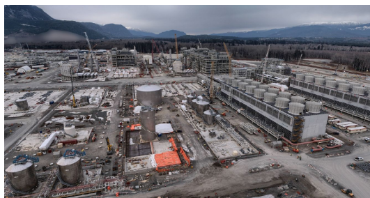
LNGカナダプロジェクト (建設中)
