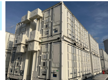
津蓄電所(建設中)
