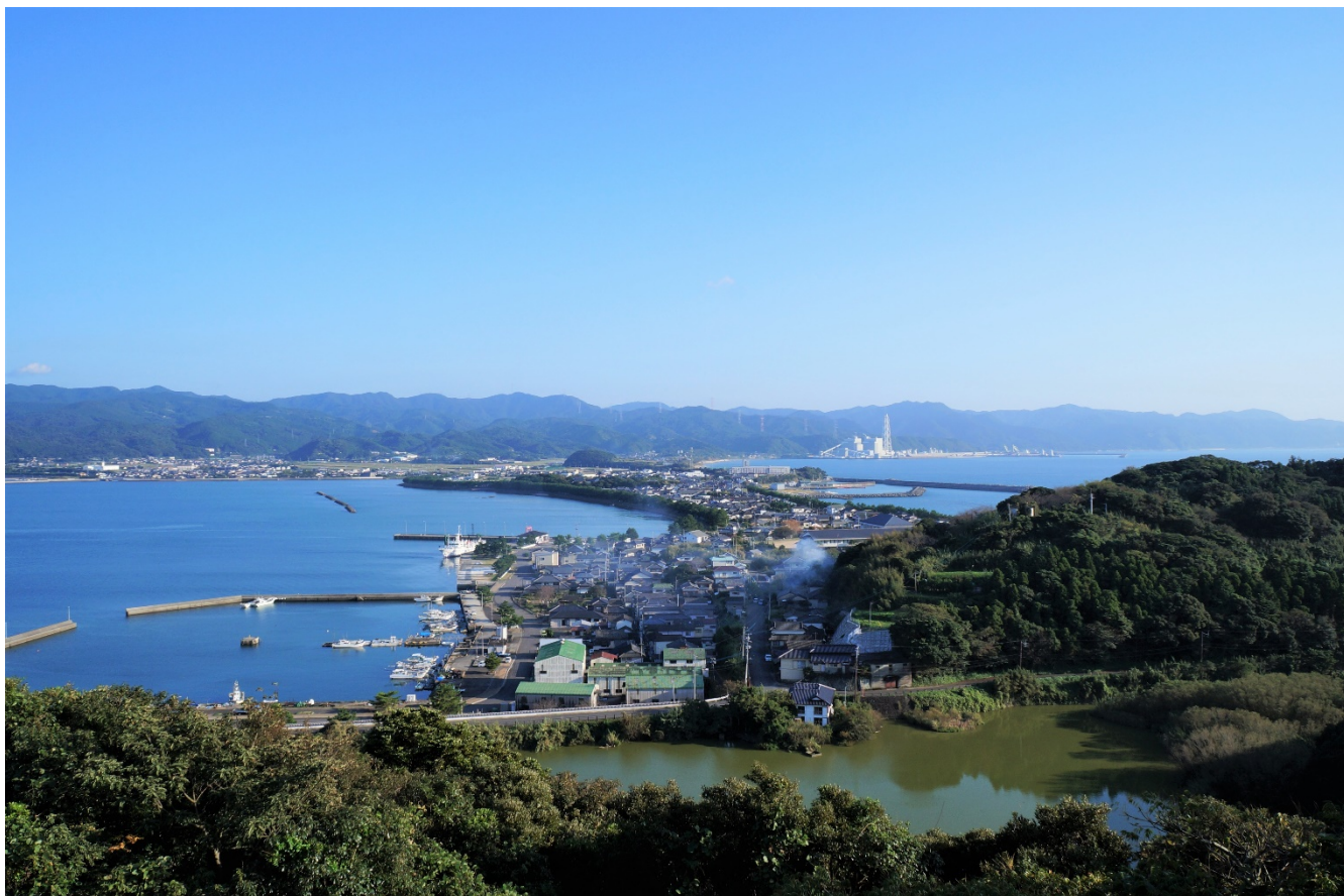
(苓北・天草風力発電所 建設予定地)
