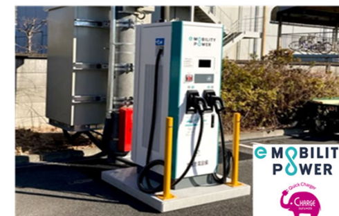
電気自動車(EV)用急速充電器設置(16台)
