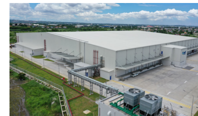
物流倉庫建設
