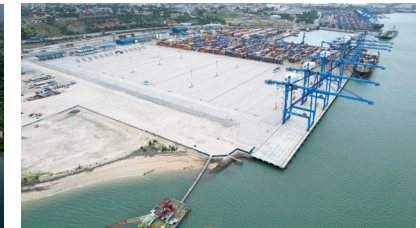
ケニア・モンバサ コンテナターミナル建設
