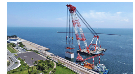
岸壁築造工事
