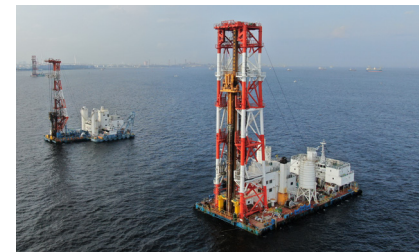
海上地盤改良工事
